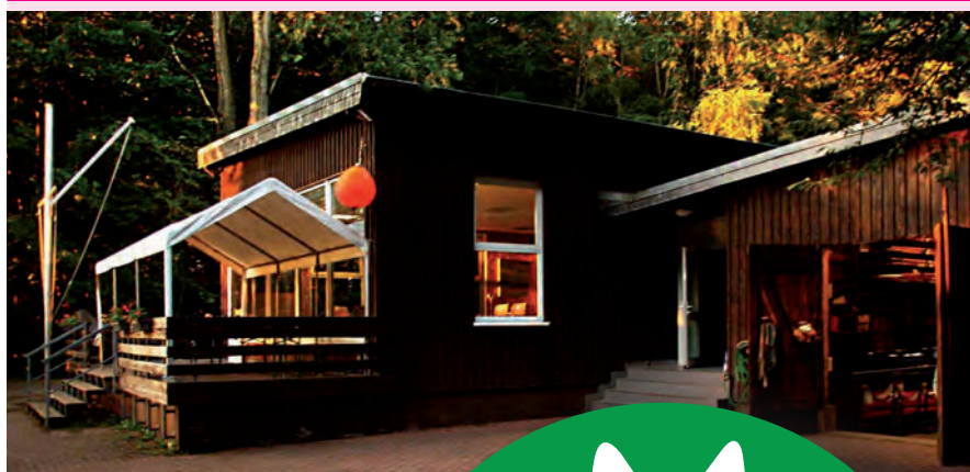
Bootshaus Unterbacher See
